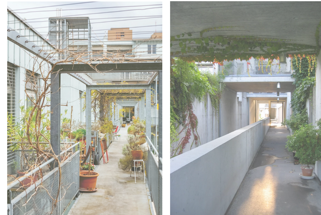
Siedlung Brahmahof, Zürich
